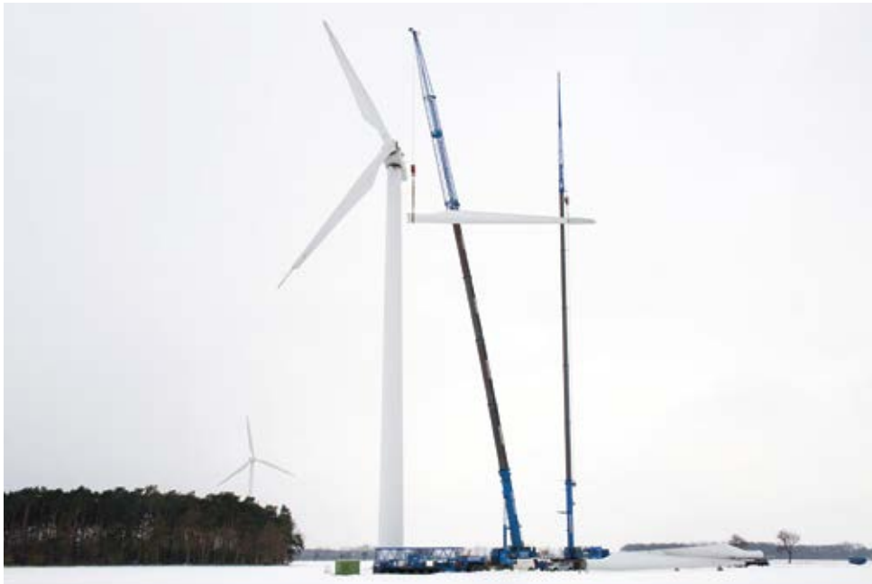
Rotorblatt-Montage an einer WEA
